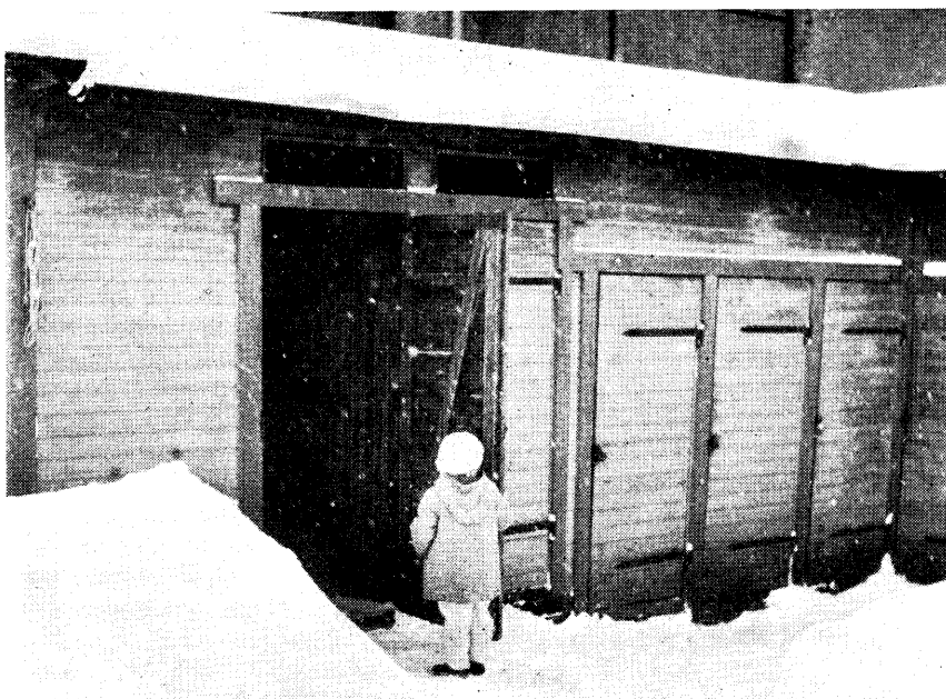
T. h. vedbodarna. Innanför den öppna dörren ligger »dassen» i en lång rad.
