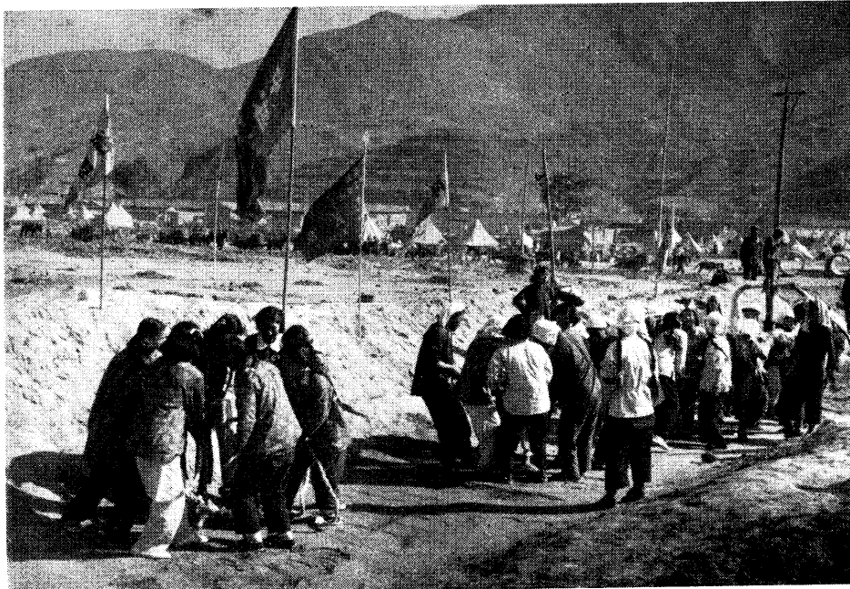
En bild från uppförandet av Ming Tombs kraftverk, som artikelförfattarinnan erinrar om. Som synes var det många kvinnor med i det arbetet.
