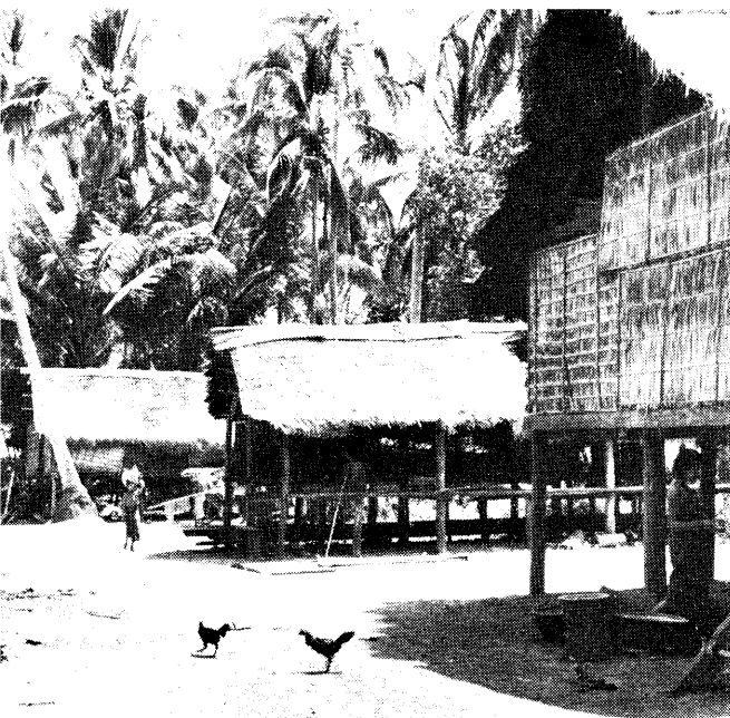
Typisk kambodjansk by: "palmtakhus" under kokospalmer.
